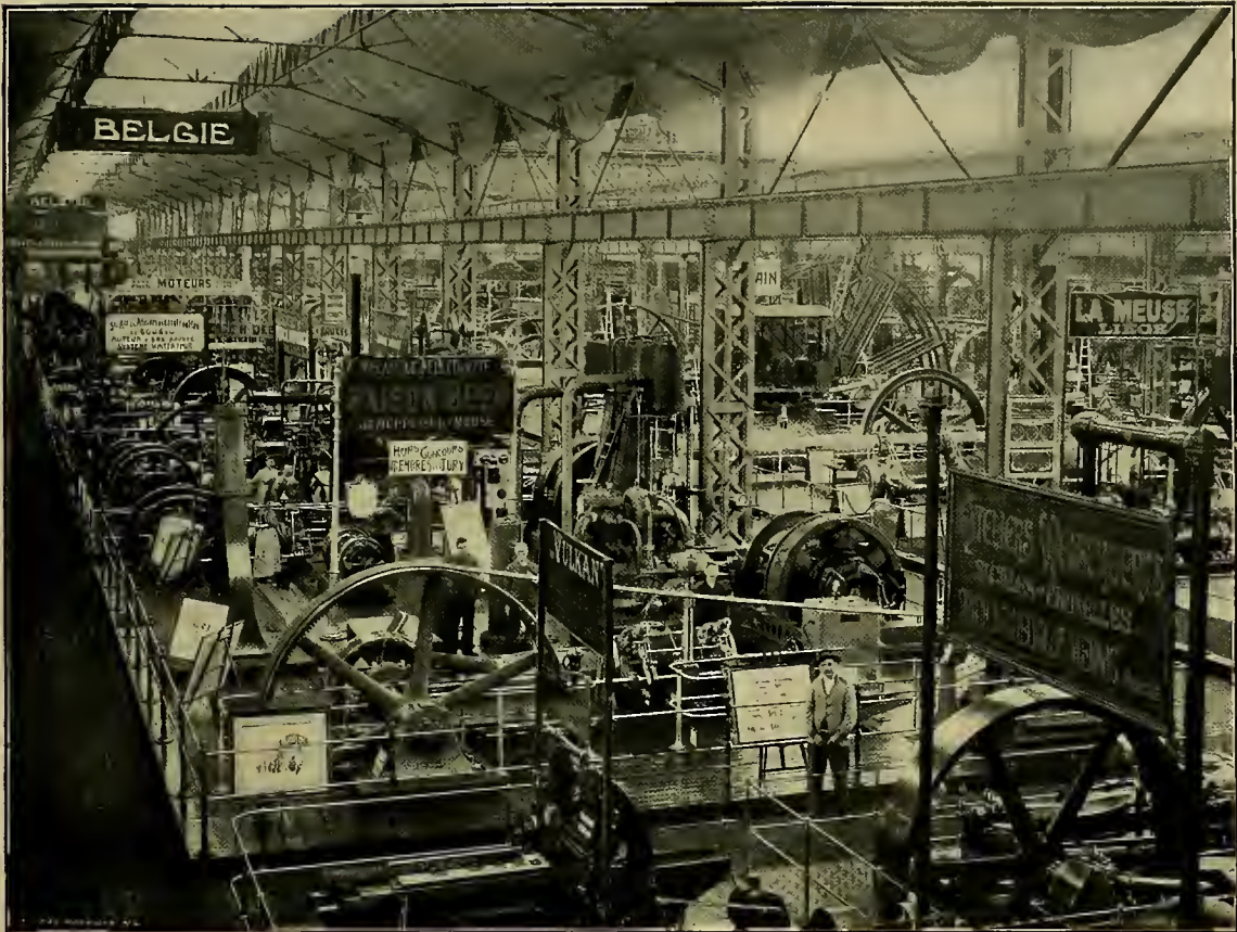
UN ASPECT DU HALL DES MACHINES.
